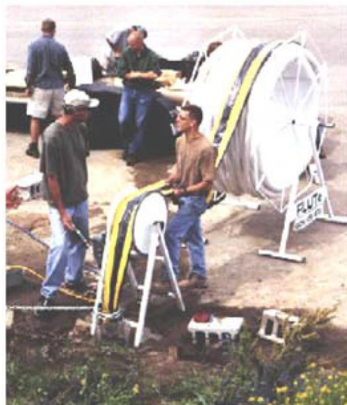
圖 1.4.6-4 充脹式襯管設置現場照片圖
