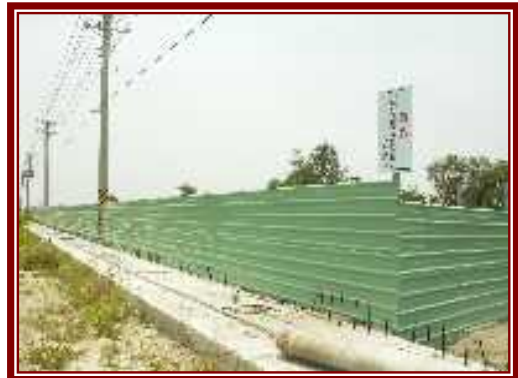
公告污染管制區、管制人員進出
