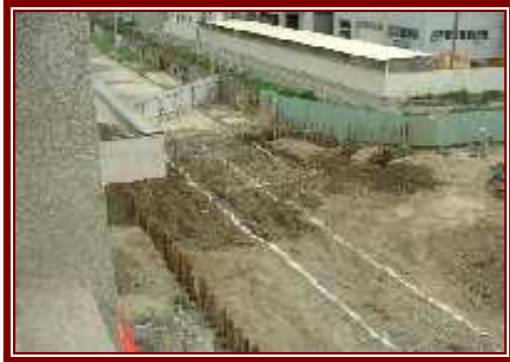
工址地表清除與放樣
