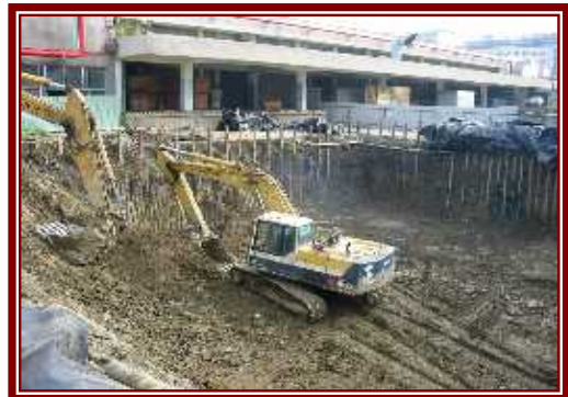
擋土與開挖工程
