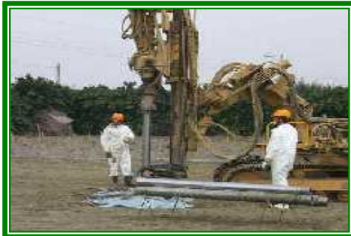
運用鑽孔方式調查採樣
