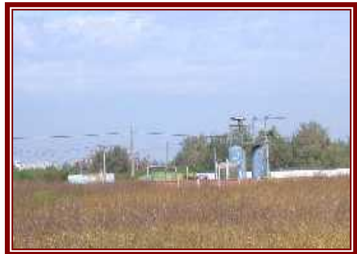
活性炭處理設施
