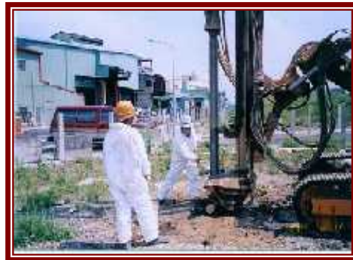
地下水監測井施作
