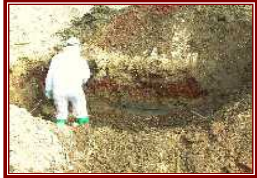
污染土壤開挖
