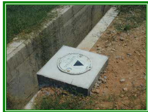
照片 4-2 隱藏式地下水監測井
