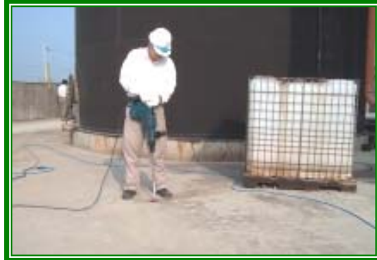
3. RC/PC 破孔
