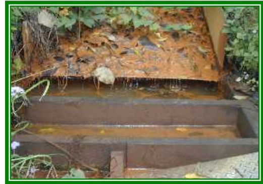
豎立告示牌禁止使用水
