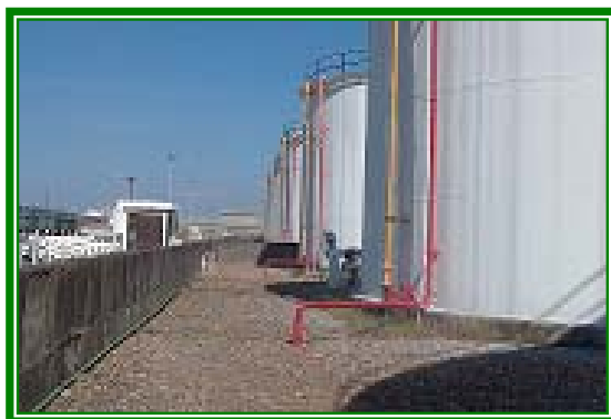
石化儲槽槽底、周邊
