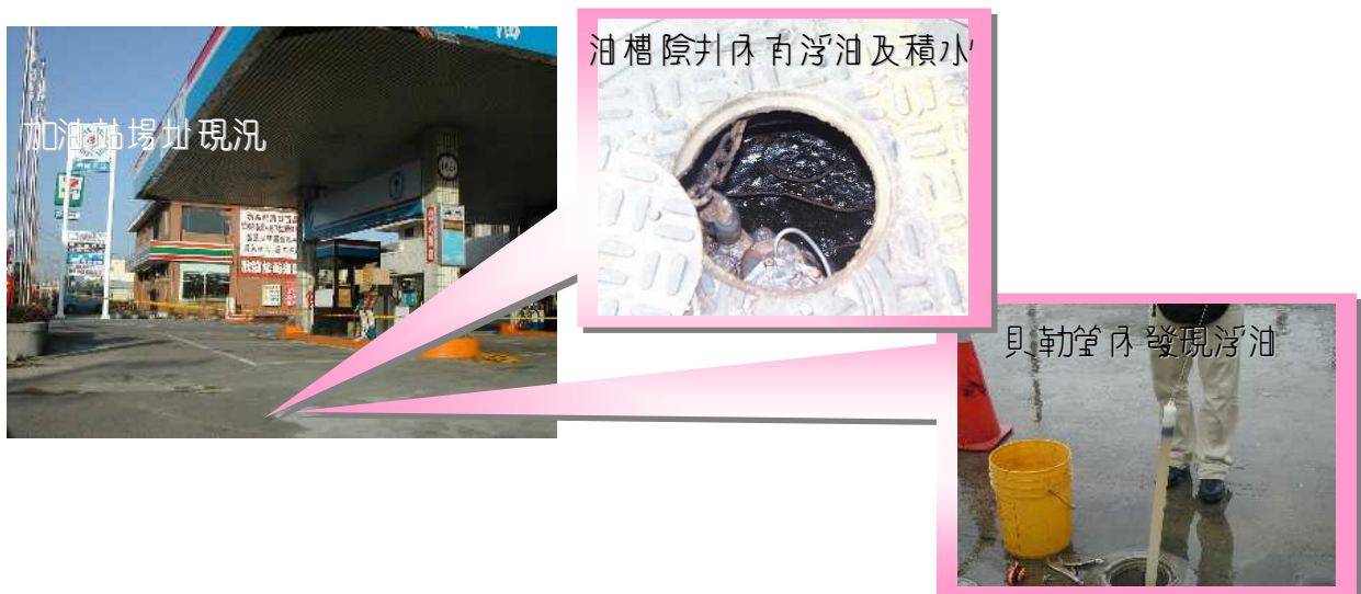
照片 7-1 加油站污染情形
